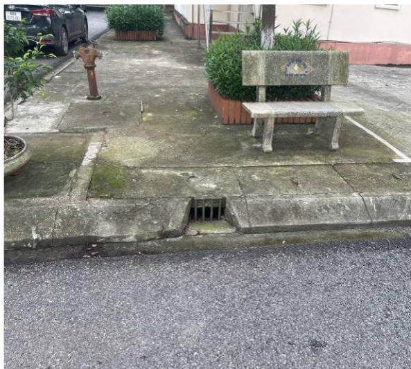
Hệ thống rãnh thu gom nước mưa tại cơ sở
