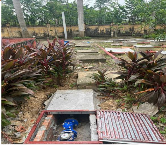
Vị trí lắp đặt đồng hồ đo lưu lượng nước thải đầu ra của hệ thống
