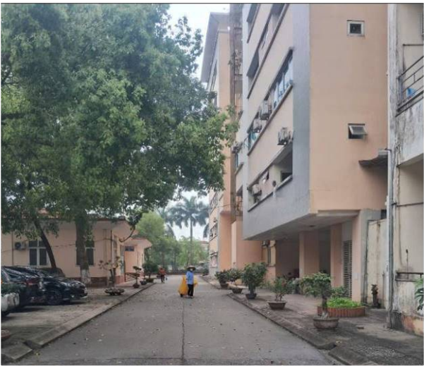
Khu nhà H
